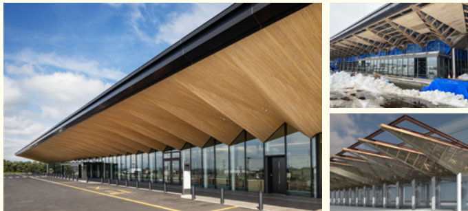
鉄骨+木ハイブリット構造のキャノピー（左） キャノピー施工状況（右上） 設計時のBM検討（右下）
