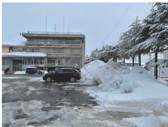
写真2 旧町役場の駐車場の状況
