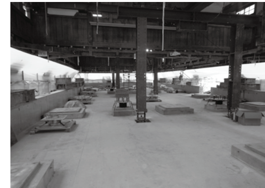
③ べた基礎施工
