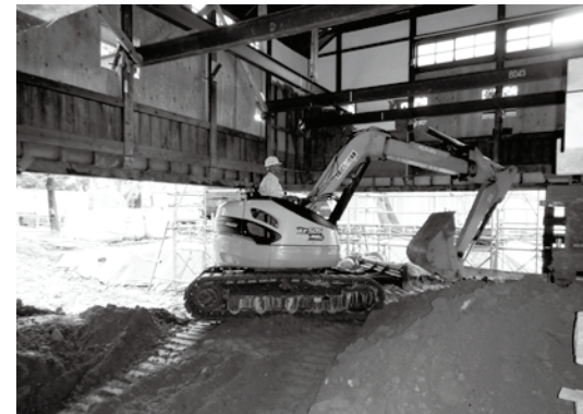
② 土工事施工
