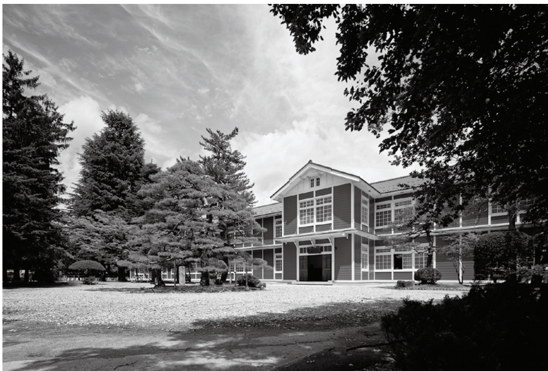
①完成後建物正面
