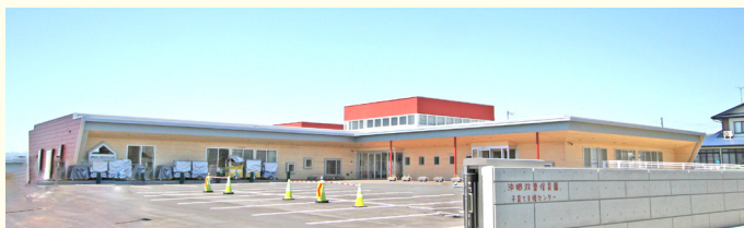
斜めのアクセント袖壁と杉板張縁側が特徴的な外観
