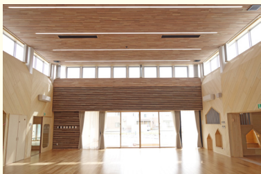
鉄骨造でありながら、木質感が感じられる遊戯室
