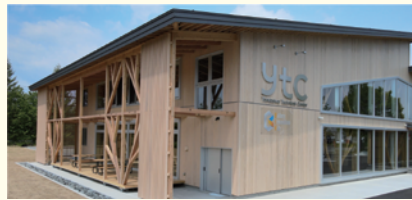
南東外観 テラスを覆う大庇
